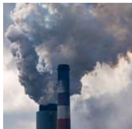
Central eléctrica, ICP
