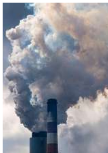
Central eléctrica, ICP
