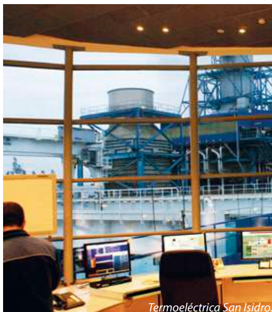
Termoeléctrica San Isidro.
