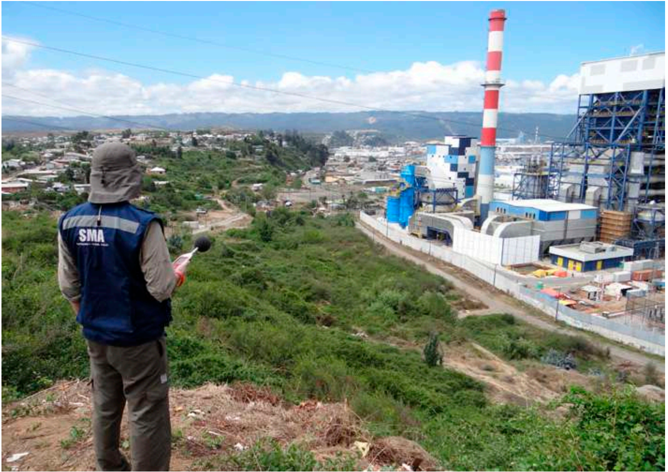
Central Termoelectrica Bocamina.
